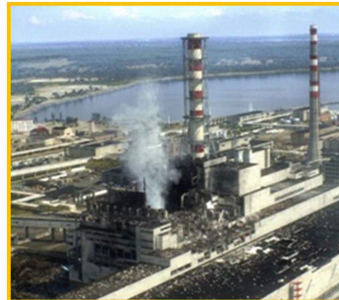
Авария на Чернобыльской АЭС
